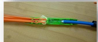
9. Grundkörperoberenteil („FiMoClip“) vorsichtig aufsetzen – dabei Kabel, Bündeladeröhrchen und Simplexschläuche nicht verschieben – und verpressen bis zum Einrasten der Klammern. (evtl. z.B. kleine Rohrzanze oder kleinen Schraubstock zu Hilfe nehmen!)
